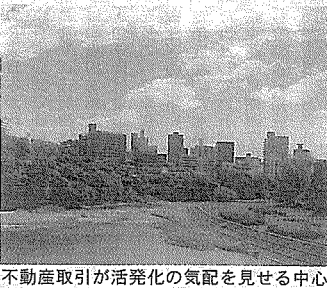
不動産取引が活発化の気配を見せる中心
