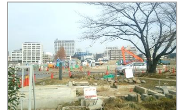
堤通雨宮町のイオンモール建設予定地 (撮影: 2018年3月)
