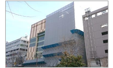
ドン・キホーテ建設中の外観 (撮影: 2018年3月)
