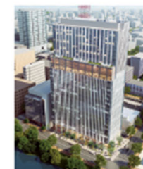
(仮称)札幌北1西5計画 2024年2月竣工予定
