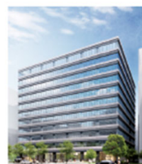
博多イーストテラス 2022年8月竣工予定
