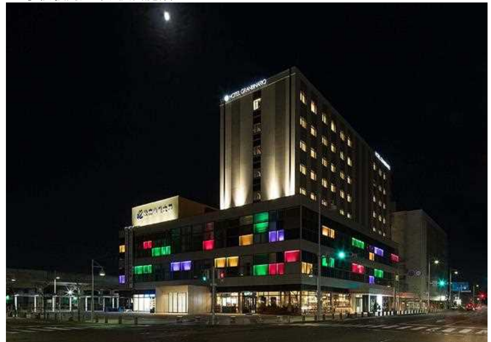
■小松駅南ブロック複合施設
