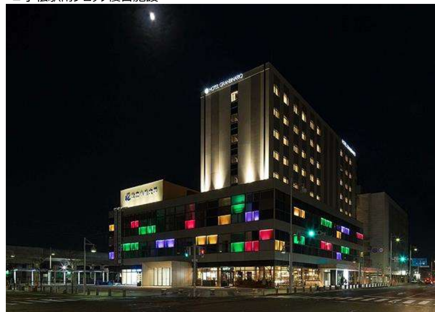
■小松駅南ブロック複合施設
